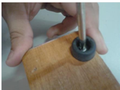
Figura 3: Fixação dos batentes de porta.
